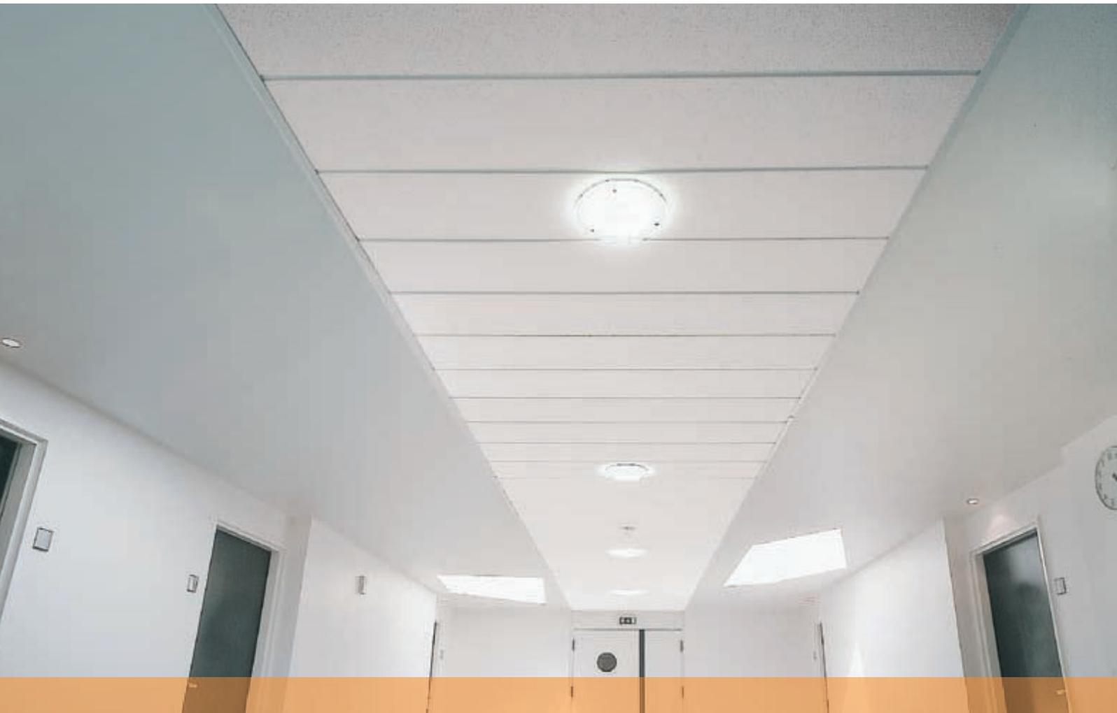
El Sistema F de AMF, es un sistema de montaje, con placas en formato panel, autoportante para pasillos.
